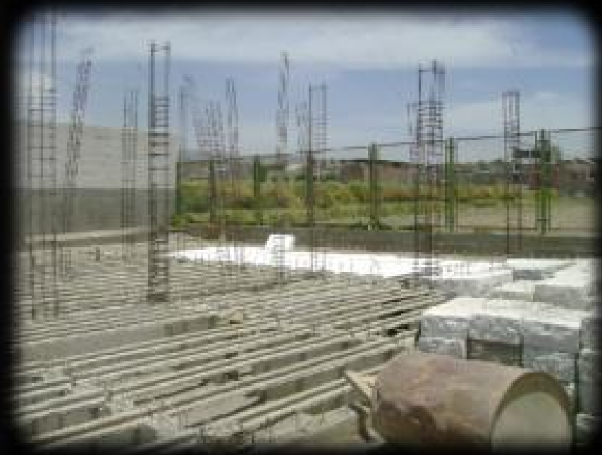
De zg. broodjesvloer, bestaande uit cementen balken, waartussen technopop wordt gelegd en vervolgens cement als toplaag.
